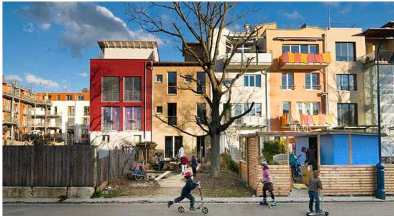
stavby z recyklovatelných materiálů - dřevo
