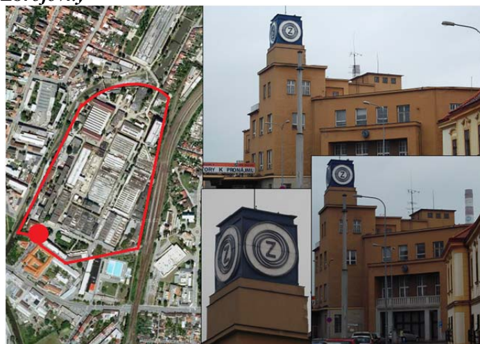
Obr. 6: Areál bývalé Zbrojovky
