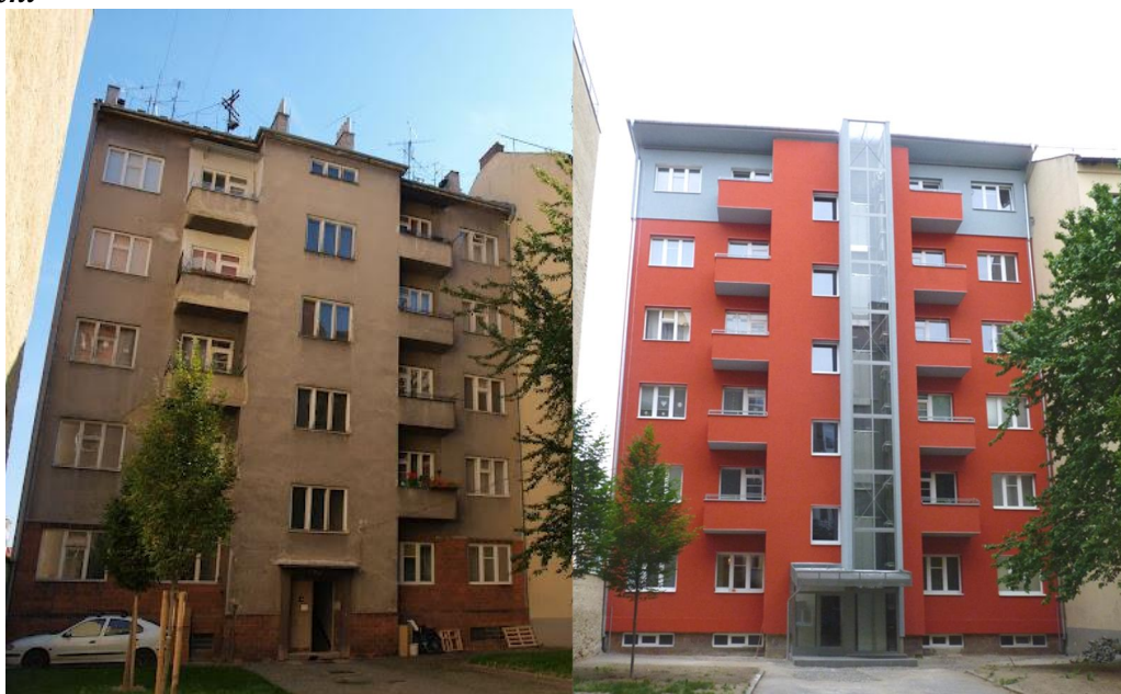
Obr. 2 a 3: Pohled na západní fasádu šzadníhoõ domu na ulici Lidická p ed rekonstrukcí a po jejím provedení
