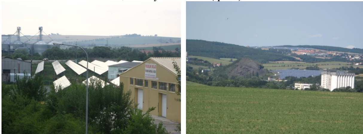
Obr. 1 a 2: Solární elektrárna v lokalitě bývalého cukrovaru ve Slavkově (vlevo) a solární elektrárna na místě částečně odtěžené haldy v Oslavanech (vpravo)
