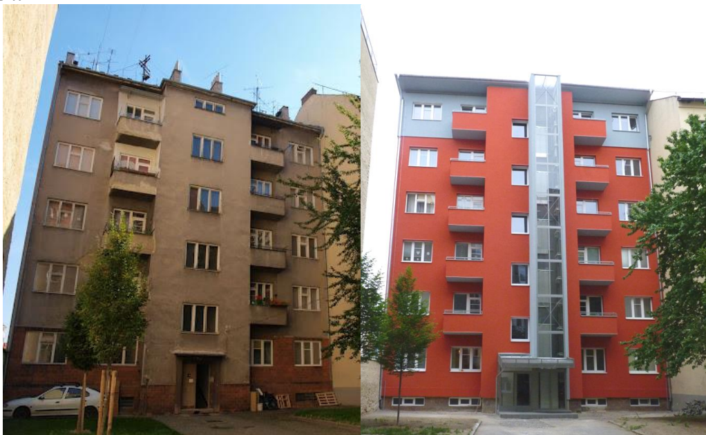
Obr. 2 a 3: Pohled na západní fasádu „zadního“ domu na ulici Lidická před rekonstrukcí a po jejím provedení
