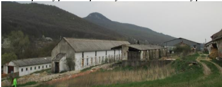
Obr. 4: Opustěný poľnohospodársky areál v obci Kostol'any pod Tribečom
