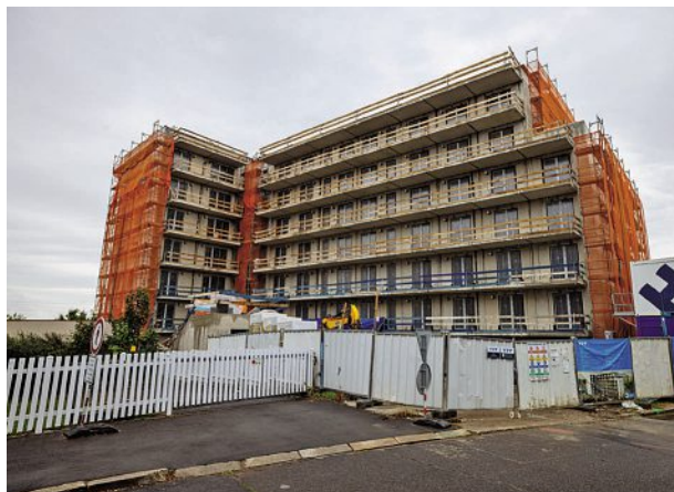
Bytový dům Happy Milánská Ize považovat za první novodobý „panelák“ v Praze. Každá zeď použitá na stavbě od druhého nadzemního podlaží výše včetně balkonů, pavlačí, schodišť a výtahových šachet přijela na nákladáku z továrny.
