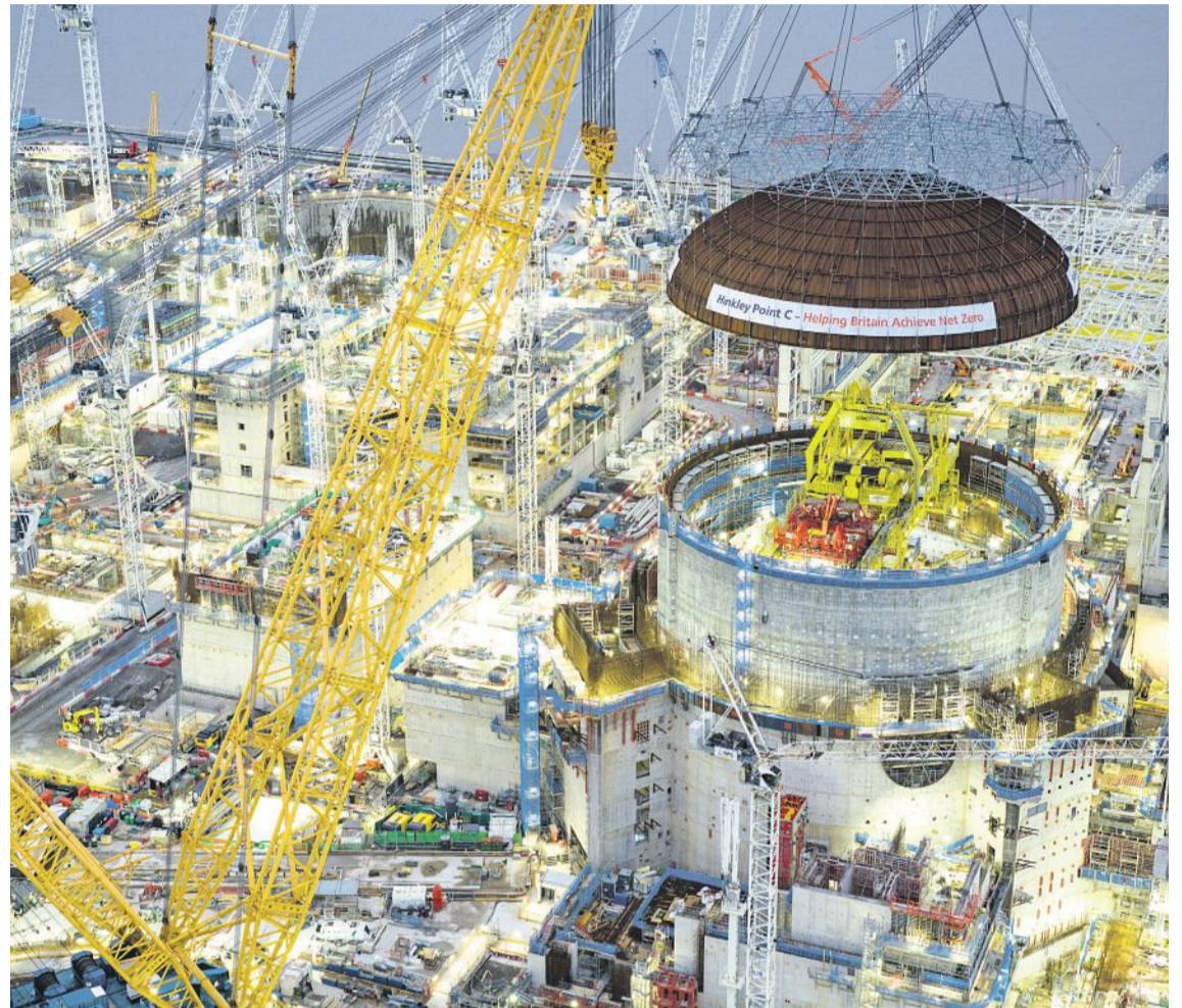
Hinkley Point C Britská elektrárna je největším jaderným projektem EDF mimo Francii. Snímek je z loňského prosince, kdy největší jeřáb na světě Big Carl instaloval kupoli jaderného reaktoru. Foto: EDF
