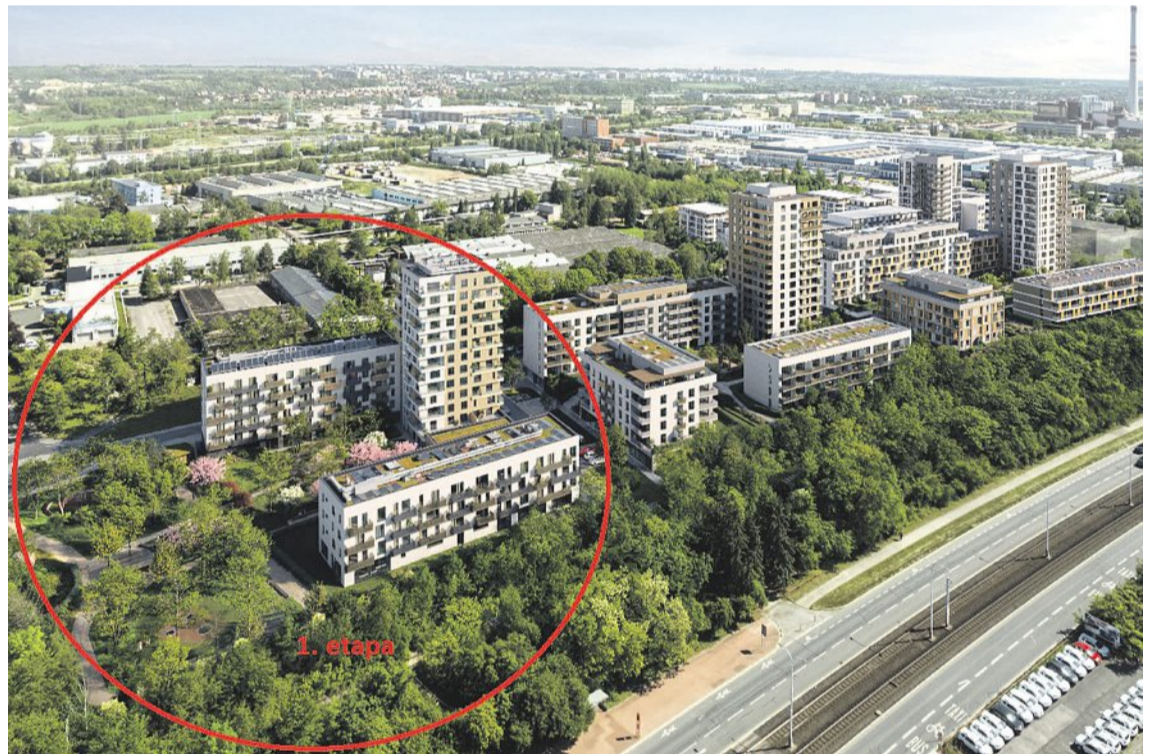
Jdou do prodeje Habitat Malešice – první domy při ulici Černokostelecká budou stát začátkem roku 2027. Foto: Skanska
