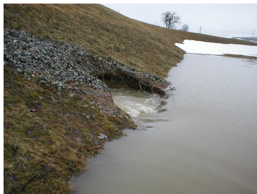
Obr.12 SN Okříšky A – propad kaverny
