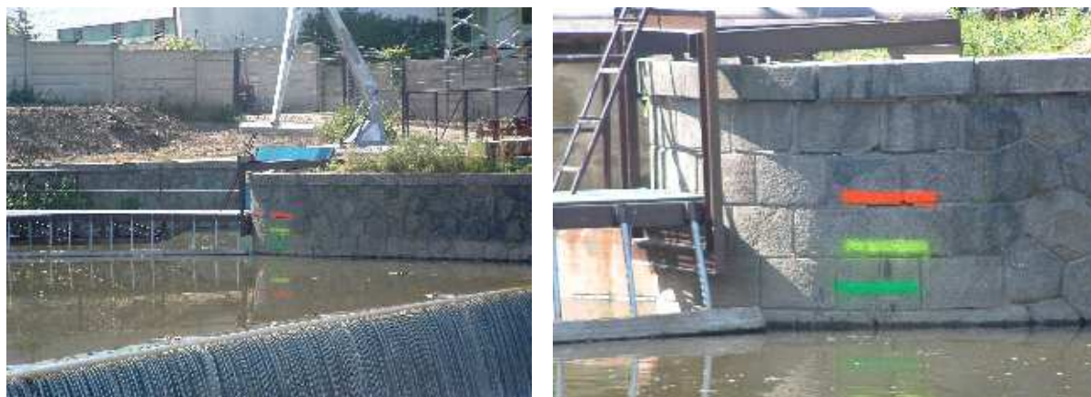
Jez Husovice – malá vodní elektrárna
