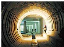
Pohled z tunelu do stanice
