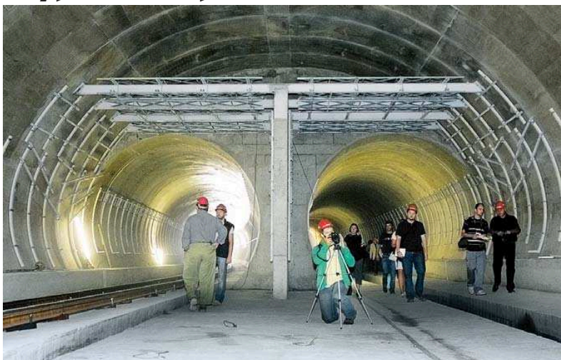
Vznikající stanice metra Letňany na trase C
