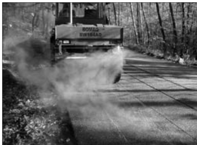
Zkušební pokládání gumoasfaltového povrchu na Karlštejsku.
