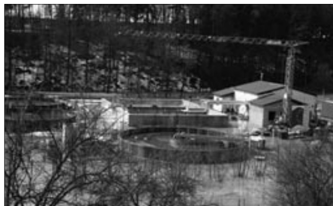
Čistička odpadních vod v Jemnici.
