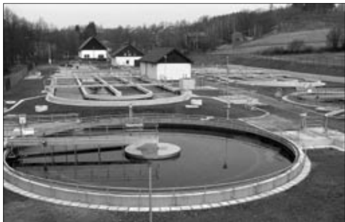
Čistička odpadních vod v Novém Městě na Moravě.
