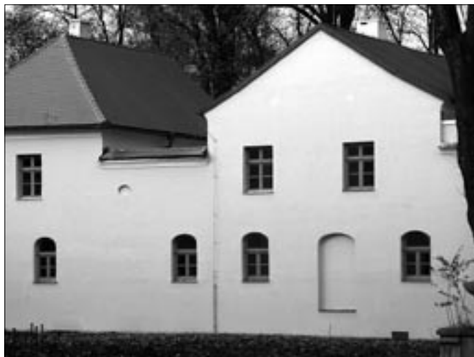
Opravené mnišské klauzury budou sloužit pro ubytování hostujících profesorů.
