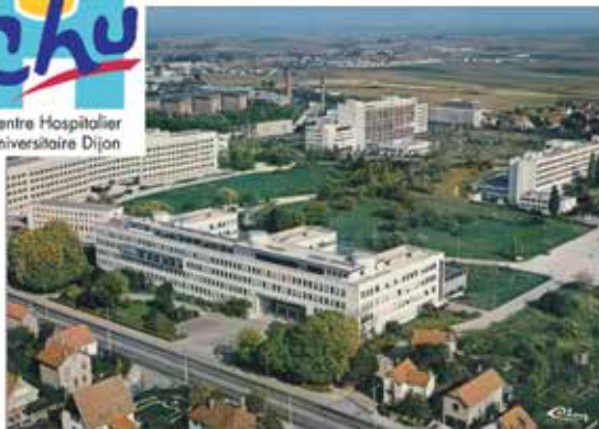
Centre de Cardiologie II, Hôpital du Bocage, Dijon, France
