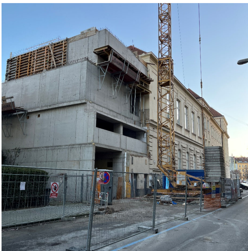
Výstavba ateliéru katedry výtvarné výchovy
