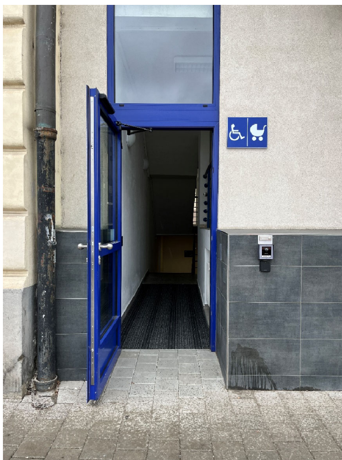
Bezbariérový vstup Poříčí 9
