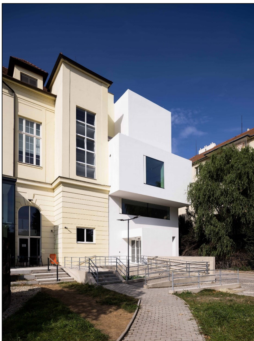
Budova nových ateliérů katedry výtvarné výchovy
