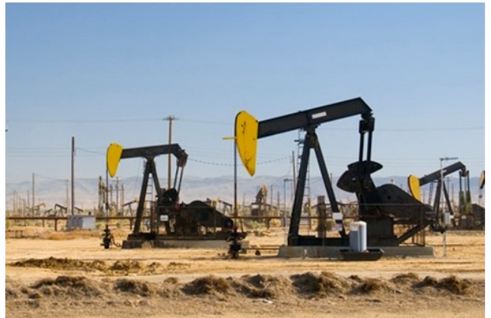
Vahadlové čerpací pumpy (Texas, USA)
