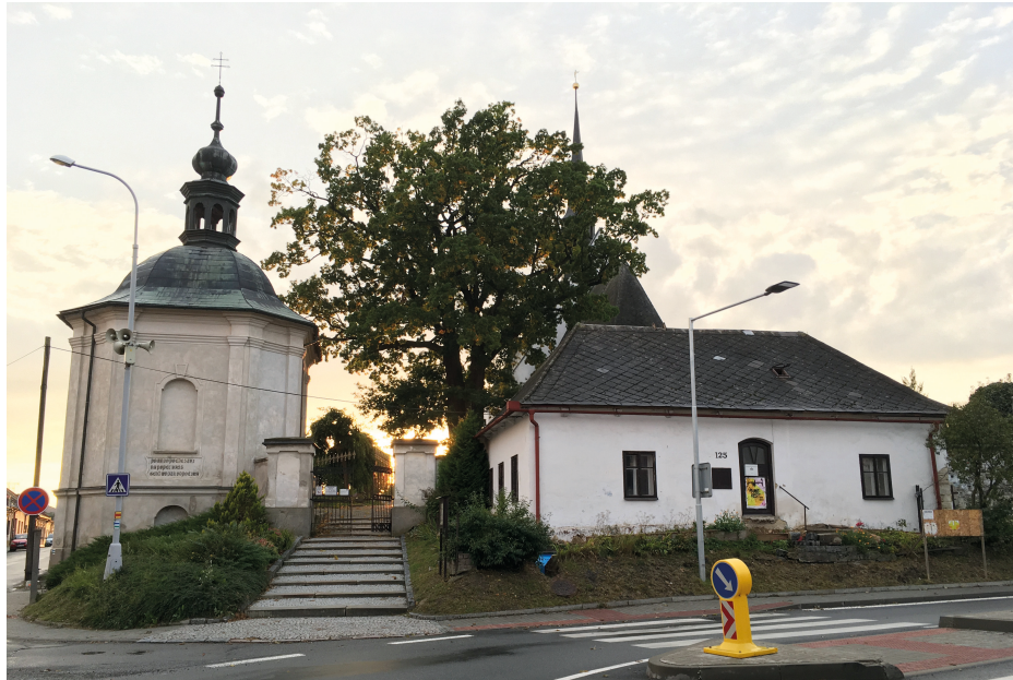
Obr. V. ▲ Michalský hřbitov v Poličce. Pohledově vpravo někdejší domek hrobníka č. 125 (nyní v rekonstrukci), vlevo pozdně barokní kostnice.
