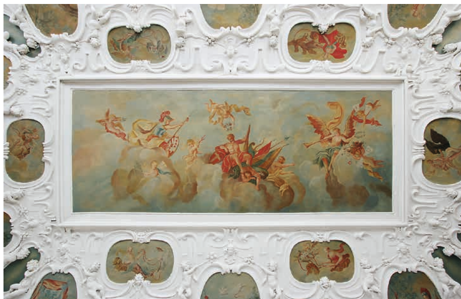
138 Strop sala terreny na zámku v Holešově.
