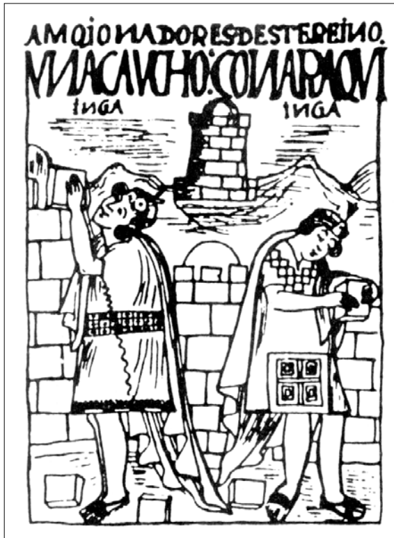
Ani jedna z nemnohých kreseb (z doby kolem roku 1600) zachycujících incké kameníky a stavitele při stavbě zdi z přesně lícovaných bloků nic bližšího o použitých nástrojích a technologiích neprozrazuje.
