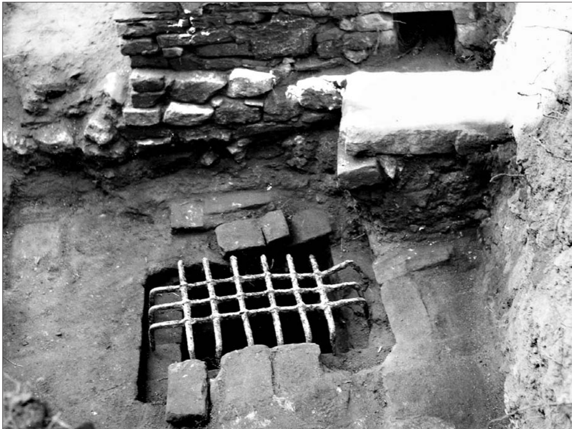
Obr. 40. Kresebná a fotografická dokumentace mříže zvané „curifraga“ patrně z 16. století nad jámou ve vstupu do areálu opevněného kostela v Kurdějově na Moravě. Kresba a foto: J. Unger.
