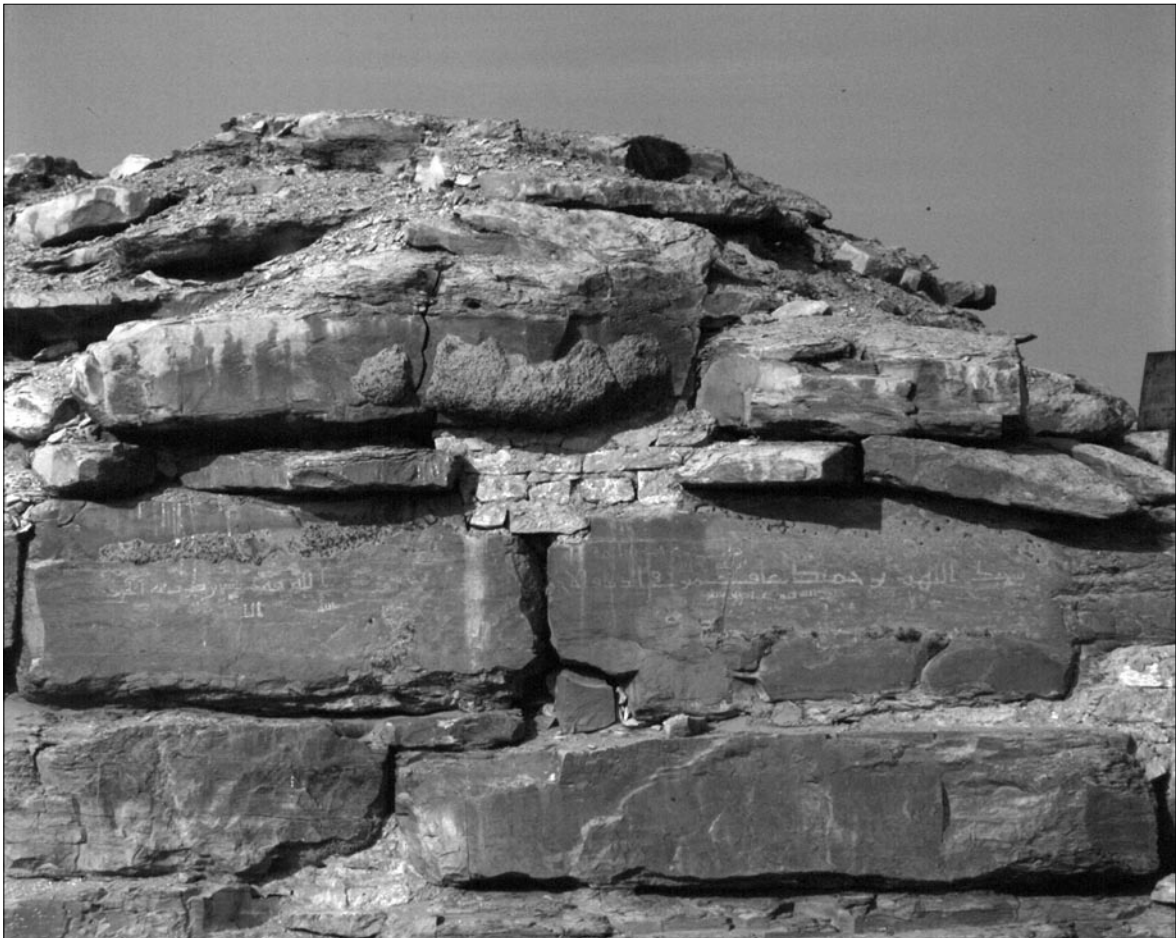
Obr. 35. Starý arabský nápis vyrytý do vápencových bloků východní stěny Neferefreovy pyramidy. (Milan Zemina)
