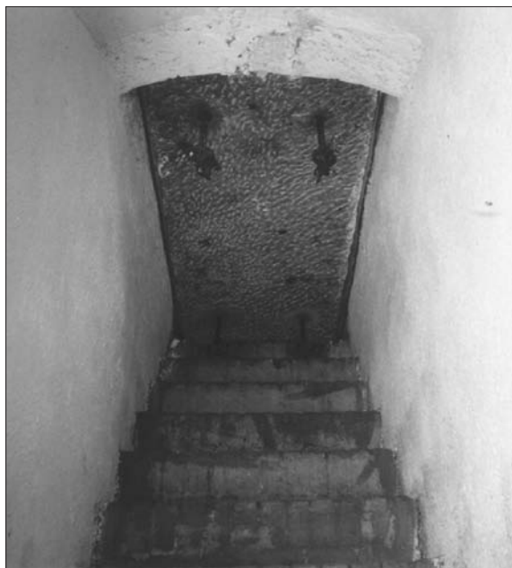
Obr. 98. Vstup do krypty skrze schody ústící otvorem v dlažbě uvnitř kostela; kapucínská hrobka v brněnském kostele Nalezení sv. Kříže (Rubinková 1997, Obr. 9.1).
