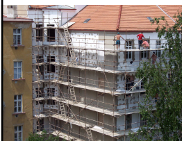
Úprava fasád se zateplením
