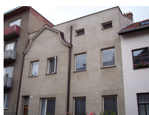
Odstranění detailu, výměna oken
