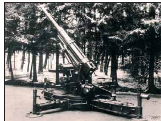
Nejmodernější palebný prostředek čs. protiletadlového dělostřelectva protiletadlový kanon vz. 37 ráže 8 cm, jímž byly v roce 1938 přednostně vyzbrojovány dělostřelecké baterie, určené k obraně Prahy
