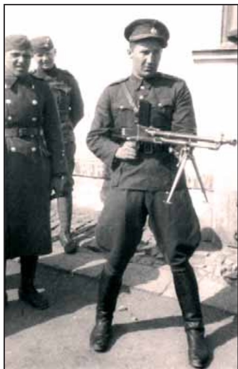
Důstojník na snímku pózuje s lehkým kulometem vz. 26. Výnikající zbraň z produkce Československé zbrojovky, a. s. Brno splňovala dva podstatné požadavky – pohyblivost a dobrý palebný výkon (30. léta).
