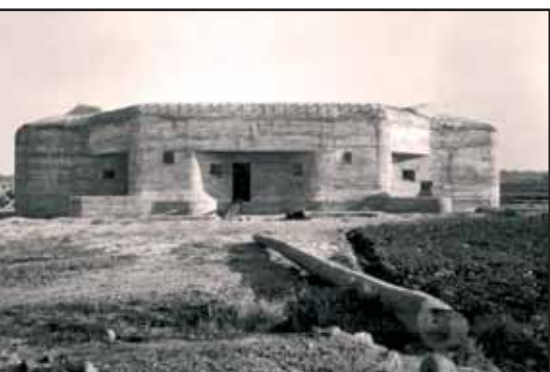
Následkem anšlusu Rakouska se začala výstavba těžkého opevnění připravovat i v exponovaném pohraničí jižní Moravy. Z plánovaných zhruba čtyřiceti urychleně vyprojektovaných těžkých objektů se podařilo do mnichovské konference vybetonovat šest izolovaných pěchotních srubů. Jedním z nich byl i objekt na snímku, jenž nesl označení MJ-S 3 „Zahrada“ (1938).
