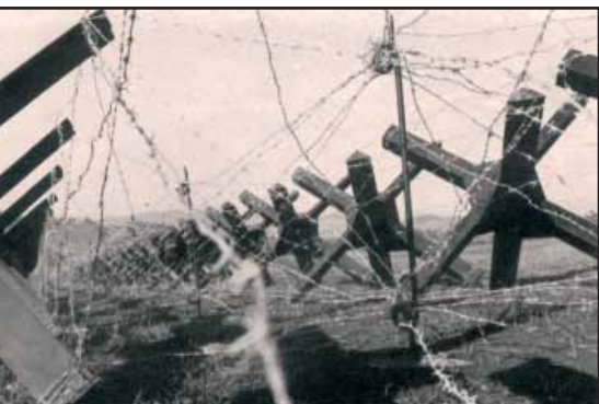
Nedílnou součást čs. stálého opevnění tvořil důmyslný systém stálých protipěchotních a protitankových překážek (1938)
