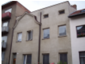
Odstranění detailu, výměna oken
