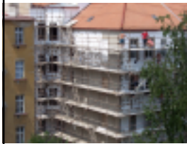
Úprava fasád se zateplením
