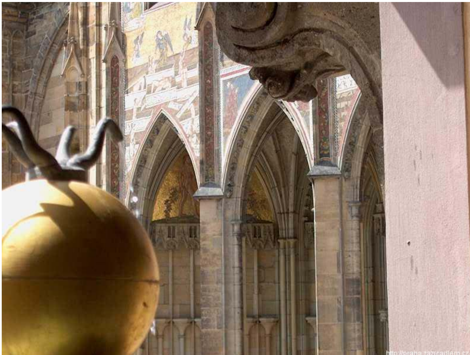
Zlatá brána, boční vstup do katedrály Sv. Víta s mozaikou Posledního soudu. Náročná oprava za přispění Gettyho nadace se uskutečnila v r. 1998.
