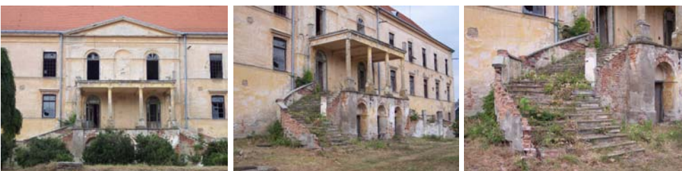
Obr. 2.14: Ukázky stavebně technického stavu historických objektů - Zámek Hrušovany nad Jevišovkou
