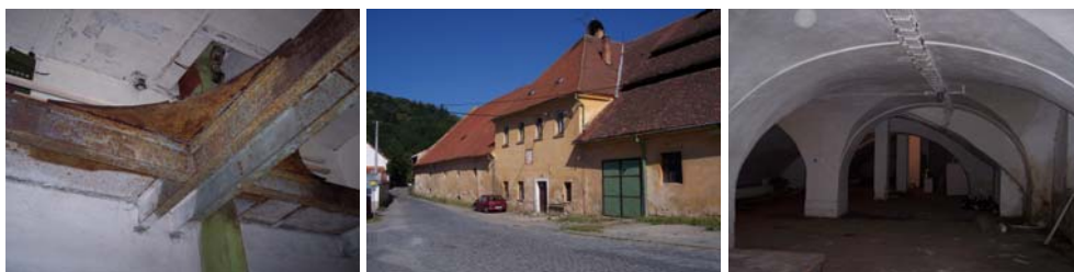
Obr. 2.11: Ukázky stavebně technického stavu historických objektů - Boskovice, bývalý zámecký pivovar
