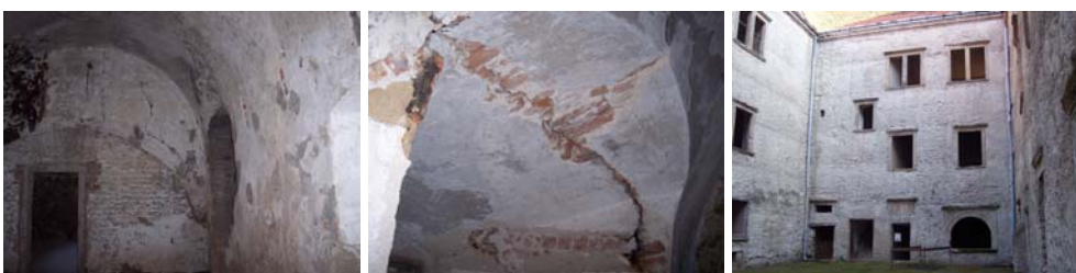
Obr. 2.12: Ukázky stavebně technického stavu historických objektů - Zámek Dolní Kounice
