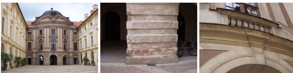
Obr. 2.15: Ukázky stavebně technického stavu historických objektů - Slavkov, nádvoří zámku, details
