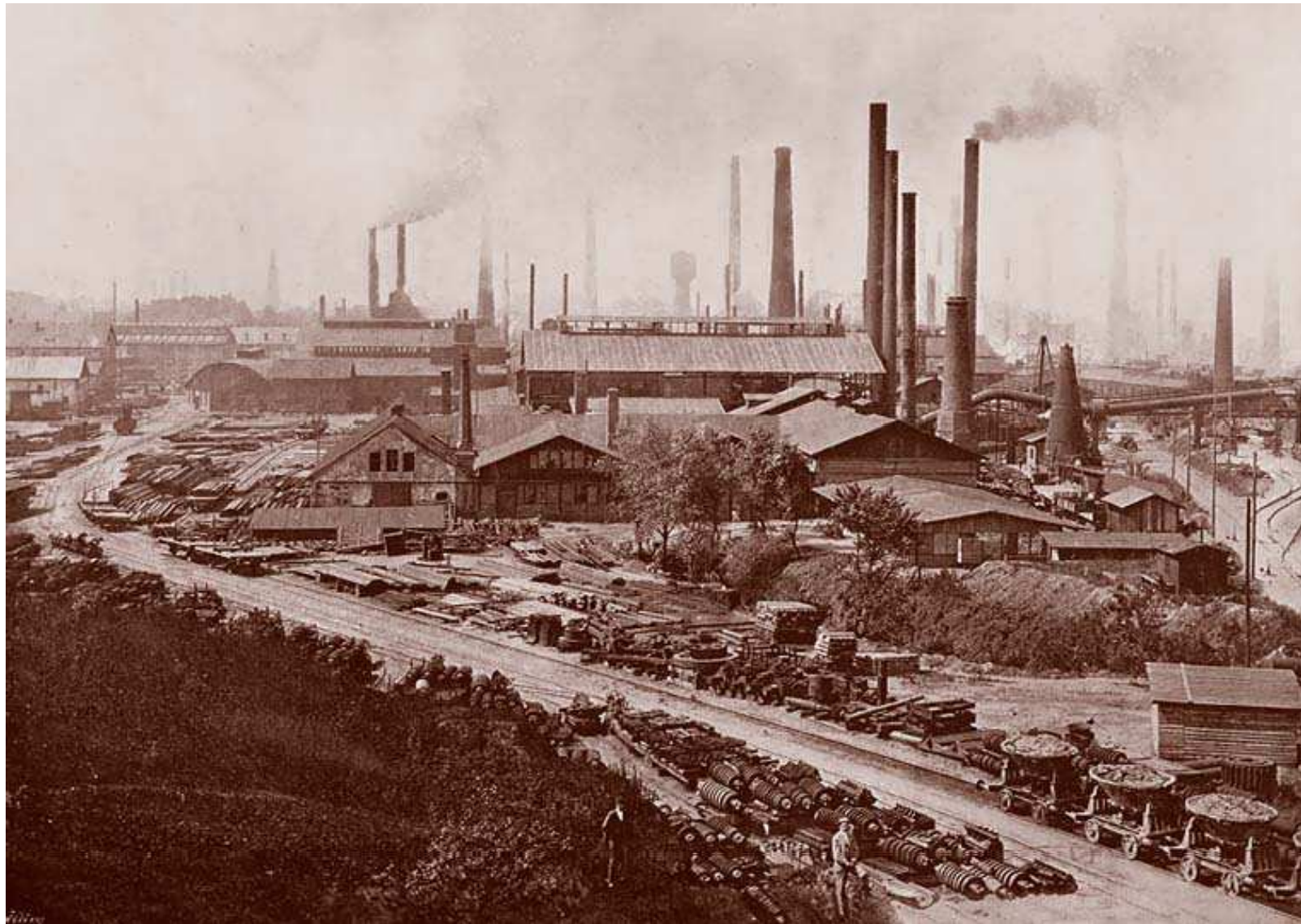
Vítkovické železářny dříve
