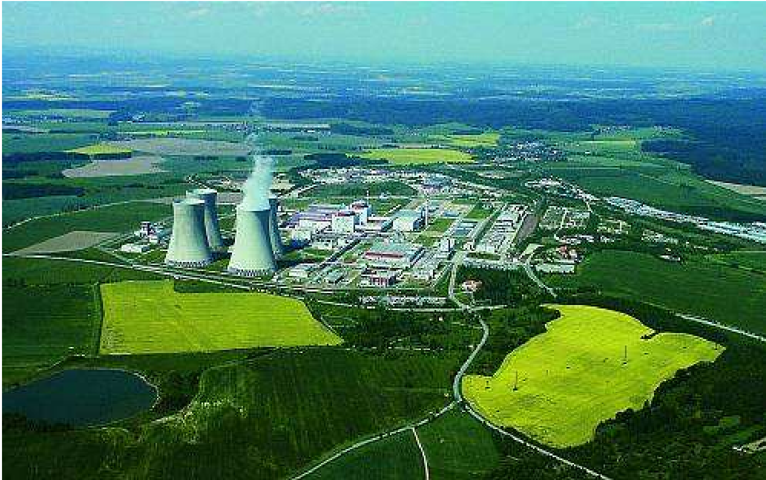
Jaderná elektrárna (Temelín)
