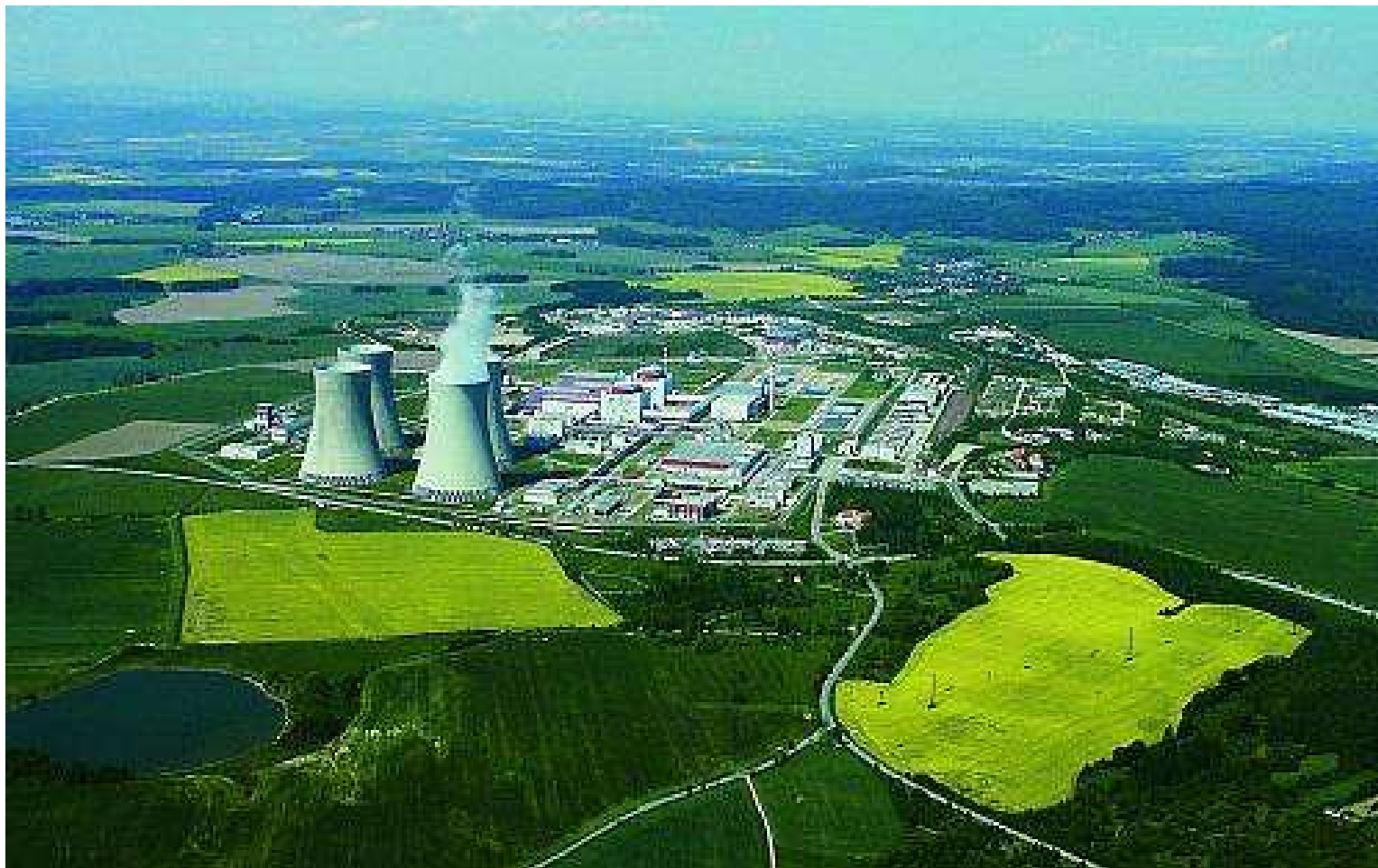
Jaderná elektrárna (Temelín)
