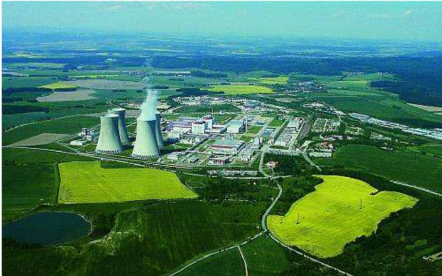
Jaderná elektrárna (Temelín)
