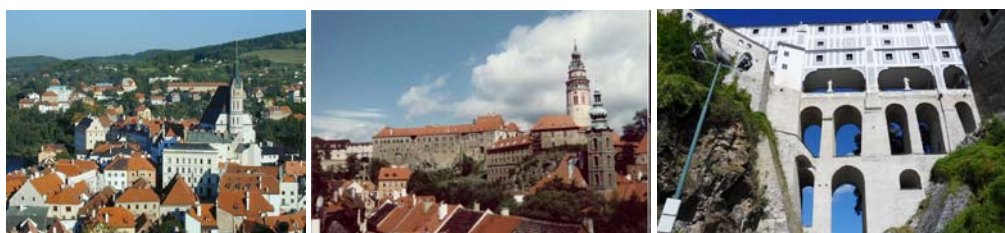
Obr.2.4: Pohled na město; Pohled na zámek; Plášťový most
