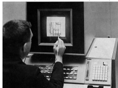
Světelné pero používané v CAD aplikacích (1964)
