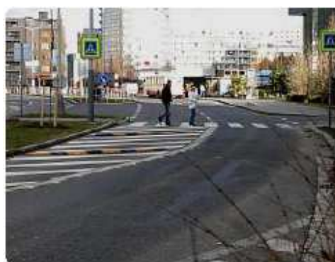
Opticko-akustické brzdy a příčné prahy, zúžení vozovky v místě přechodu přes Olbrachtovu ul., Praha 4 – ZŠ Poláčkova (projekt Bezpečné cesty do školy, Pražské matky ve spolupráci s MHMP, 2004, realizace 2004)
