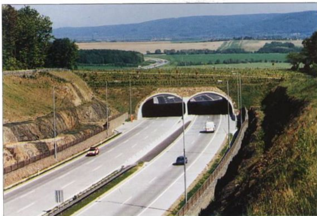
Foto 2 – Ekodukt tunelovitého typu u Lipníku nad Bečvou
