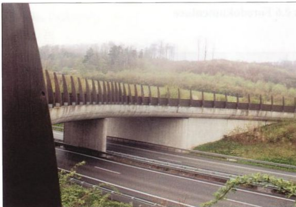
Foto 3 – Ekodukt s hyperbolickým půdorysem (u Luxemburgu) je pravidelně užíván srnčí zvěří, jelenem, jezevcem ale i dalšími druhy
