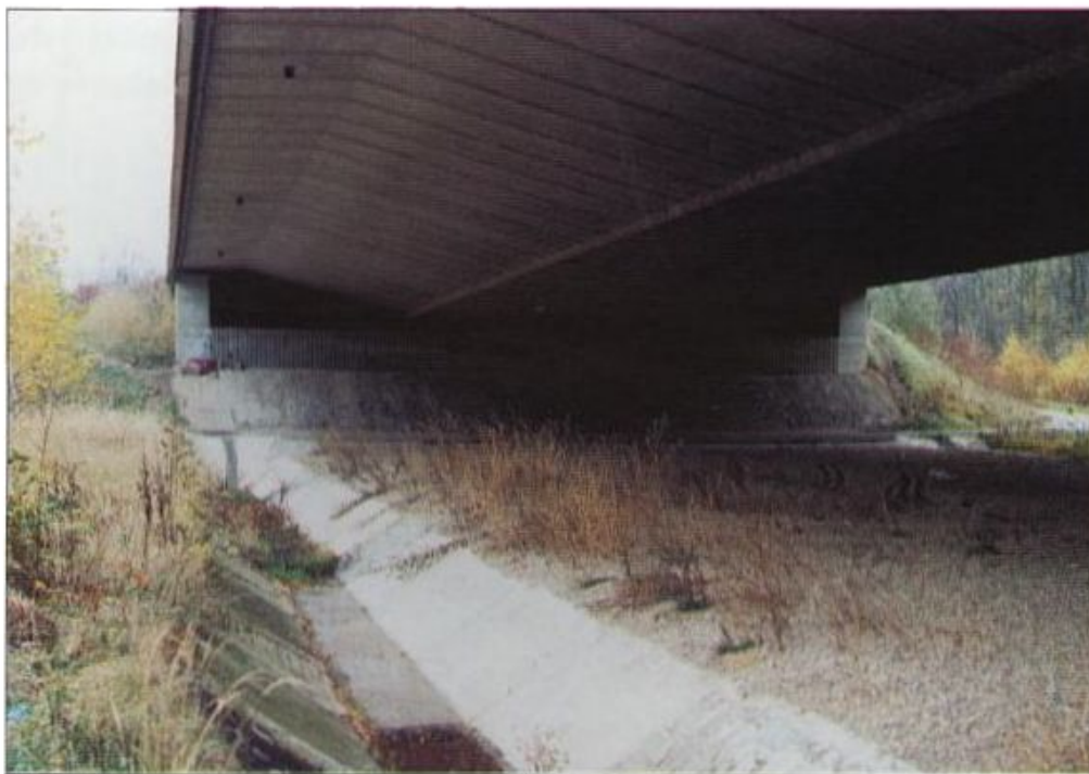
Foto 9 – Průchodnost omezuje také štěrkové zpevnění podmostí (D11)
