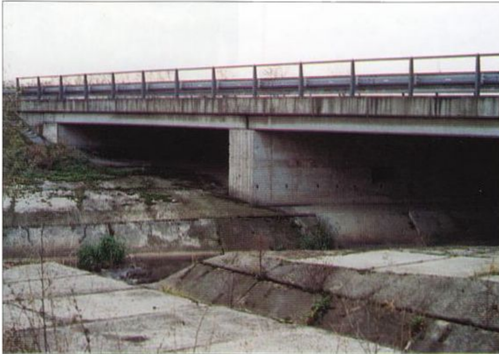
Foto 8 – Značný vliv na využitelnost mostů pro migraci živočichů má úprava podmostí. Vybetonovaná koryta recipientů a betonové zpevnění podmostí může zcela zlikvidovat migrační význam mostů (D11)
