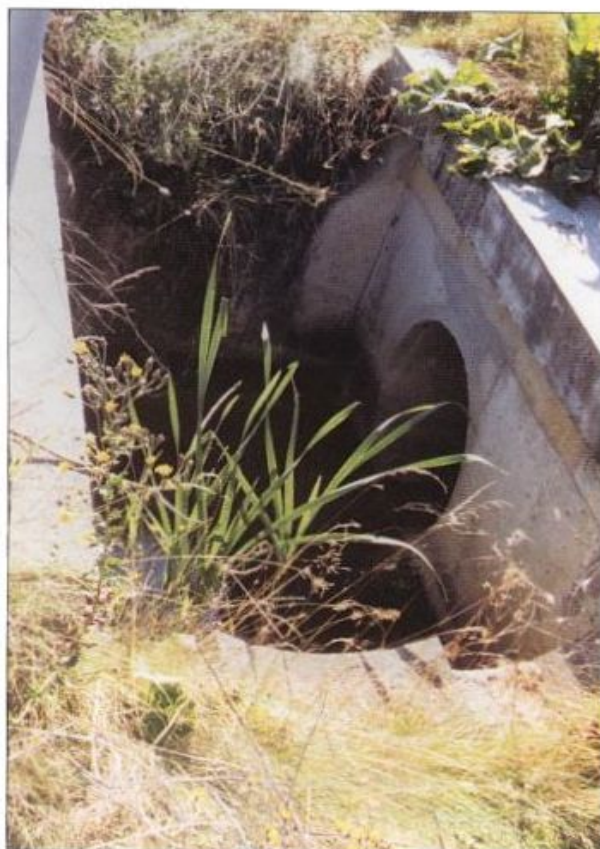
Foto 6 – Jímky před propustky vytvářejí často smrtelné pasti pro obojživelníky a drobné savce
