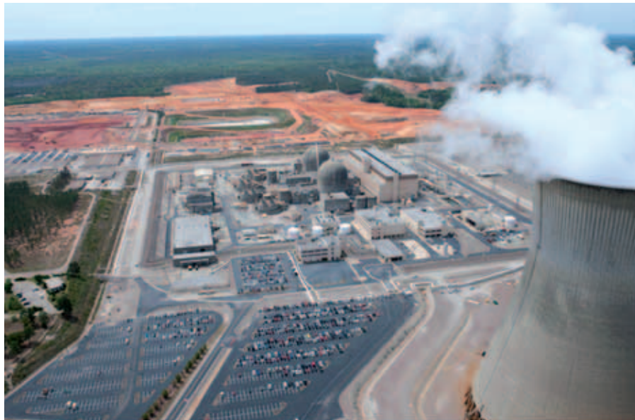
První nová jaderná elektrárna v USA po téměř třiceti letech se staví v lokalitě Vogtle s reaktory III+ generace od firmy Westinghouse.
