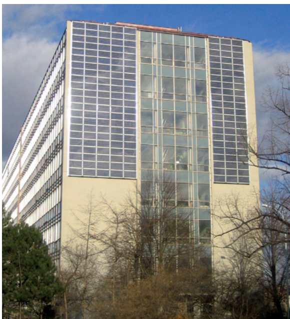
Fotovoltaický systém na budově Českého vysokého učení technického v Praze Dejvicích
