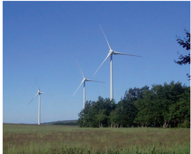
Obr. 7: Tři větrné elektrárny Enercon E–70 s výkonem 2 MW na tubusech o výšce 80 m v lokalitě Vrch tří Pánů v blízkosti Bouřňáku (autor S. Buchta)
