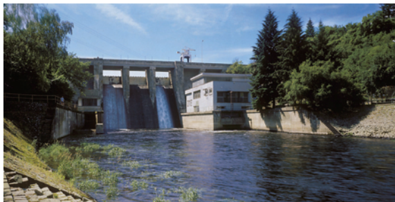
MVE Brno Kníničky
