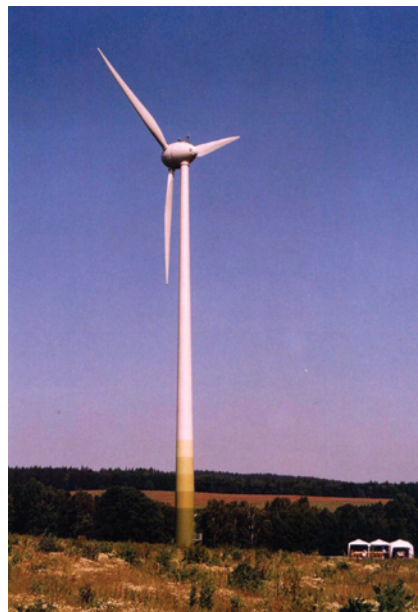
Obr. 6: Větrná elektrárna Enercon E-40 u Jindřichovic pod Smrkem (autor B. Koč)
