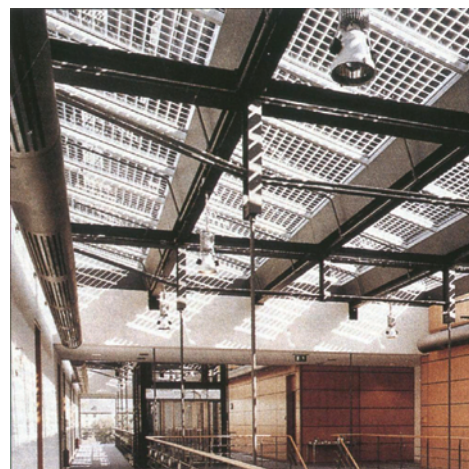
Transparentní část střechy se solárními články (obr. 5)
