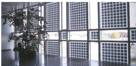
Transparentní fasáda se solárními články při pohledu z interiéru (obr. 4)
