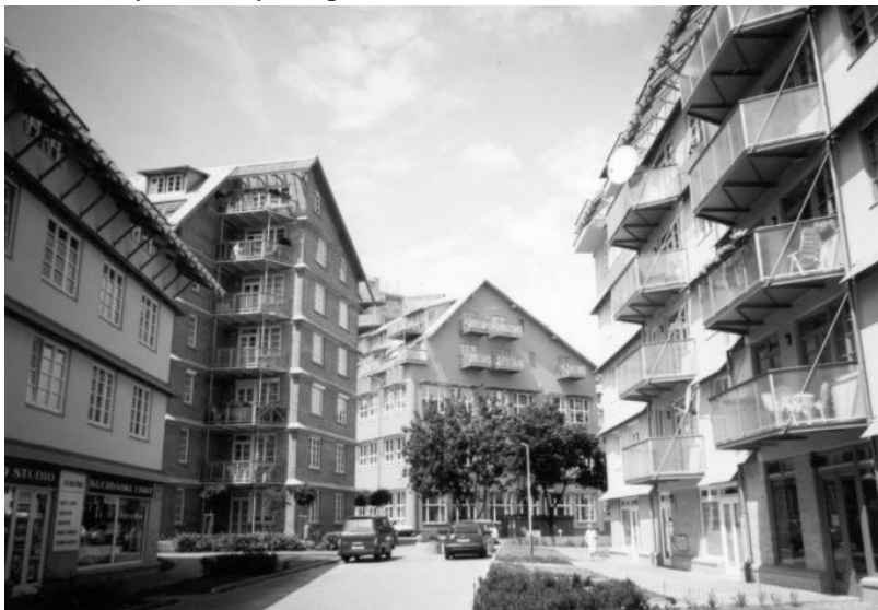
Obr. 7.6: Bytové domy komplexu Hvězda na Petřinách
