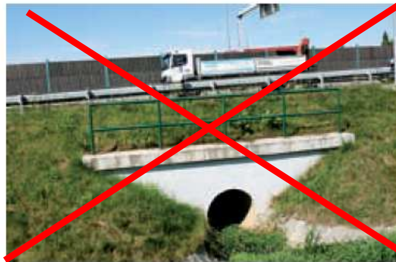
Obr. 6: Kombinace neprůchodného propustku a protihlukové stěny
