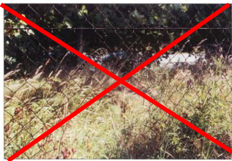
Foto 11 – Dálniční oplocení – pokud je oplocení umístěno až vně zeleného pásu na zářezech a náspech, zvěř se četnými otvory dostává do zaplaceného prostoru (D1)
