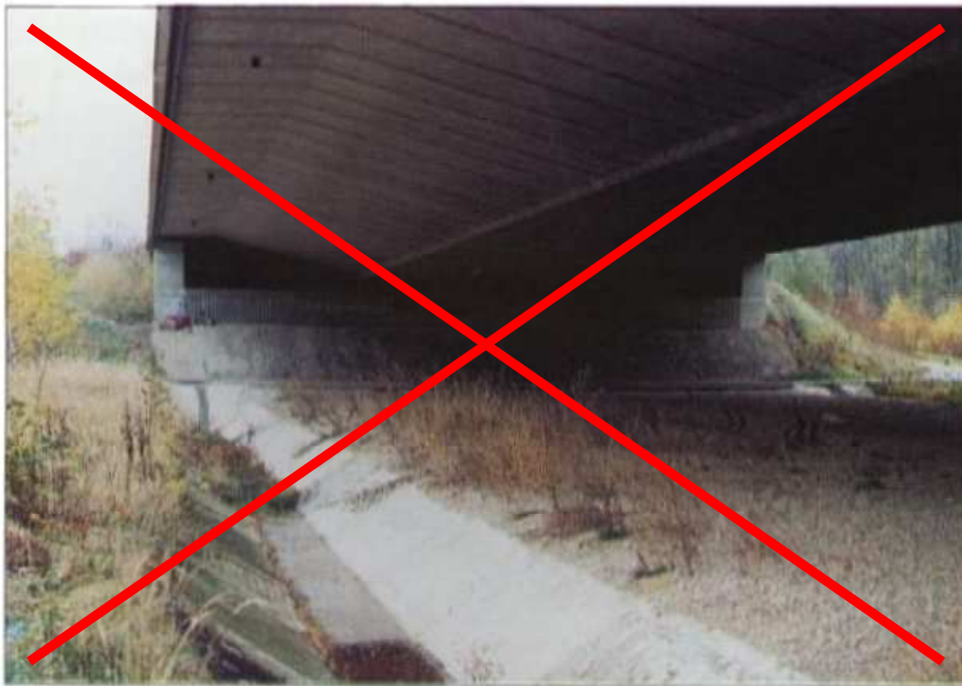
Foto 9 – Průchodnost omezuje také šterkové zpevnění podmostí (D11)
