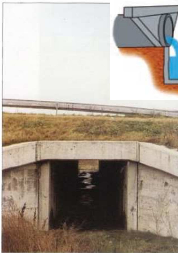
Foto 5 – Rámový typ propustku – nejvhodnější řešení
