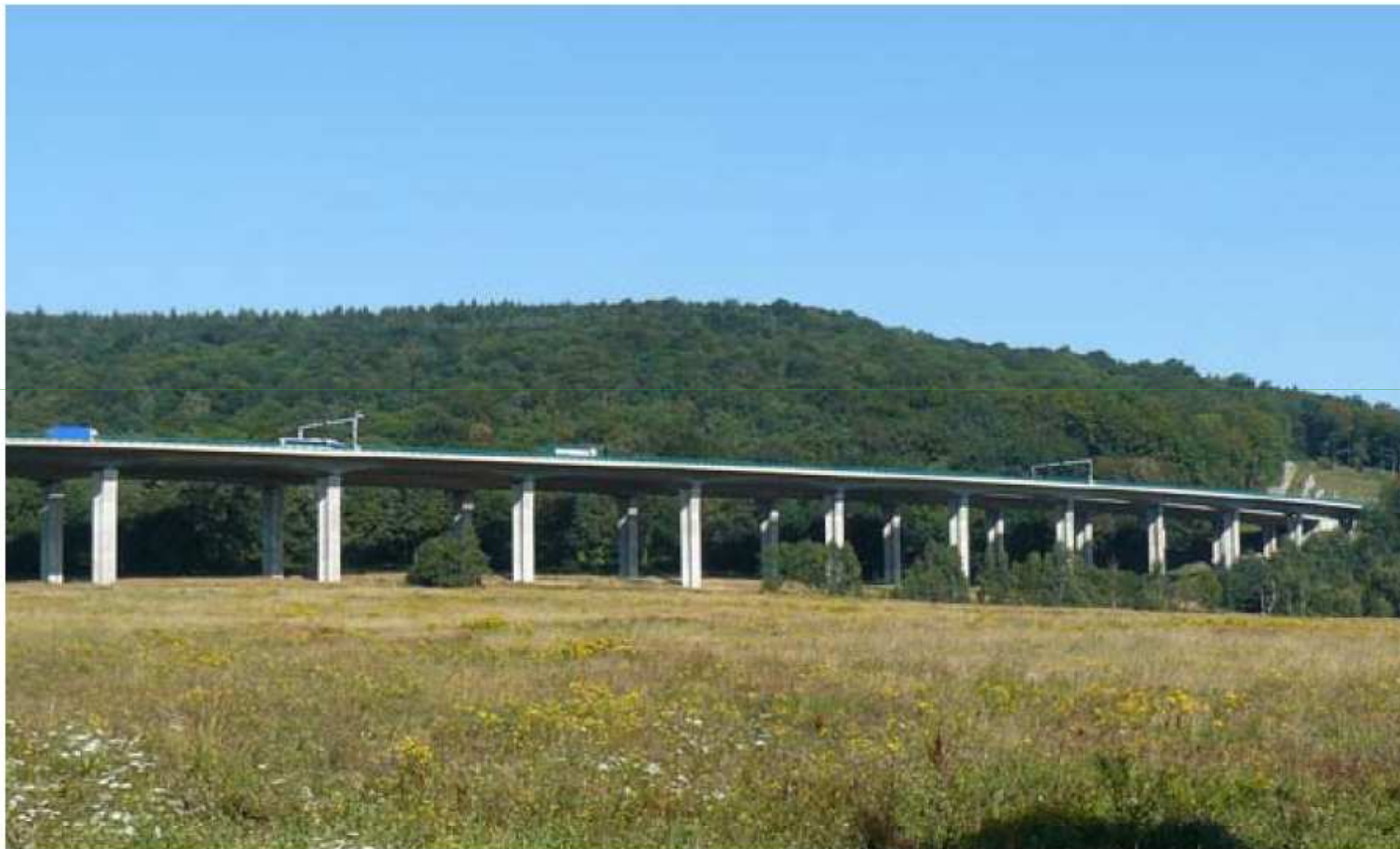
Obr. 3-2 Vysoký most je objektem, který snižuje bariérový efekt komunikace
