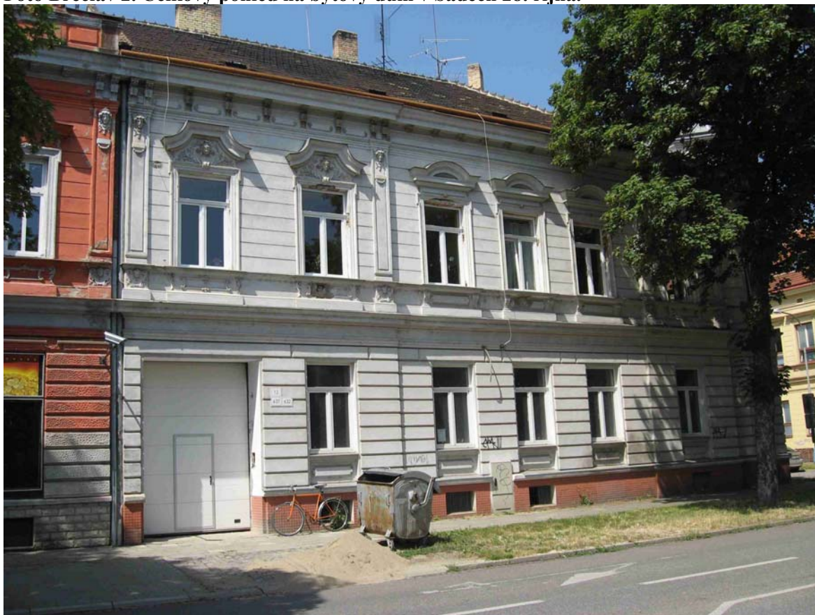
Foto Břeclav 2. Celkový pohled na bytový dům v Sadech 28. října.
