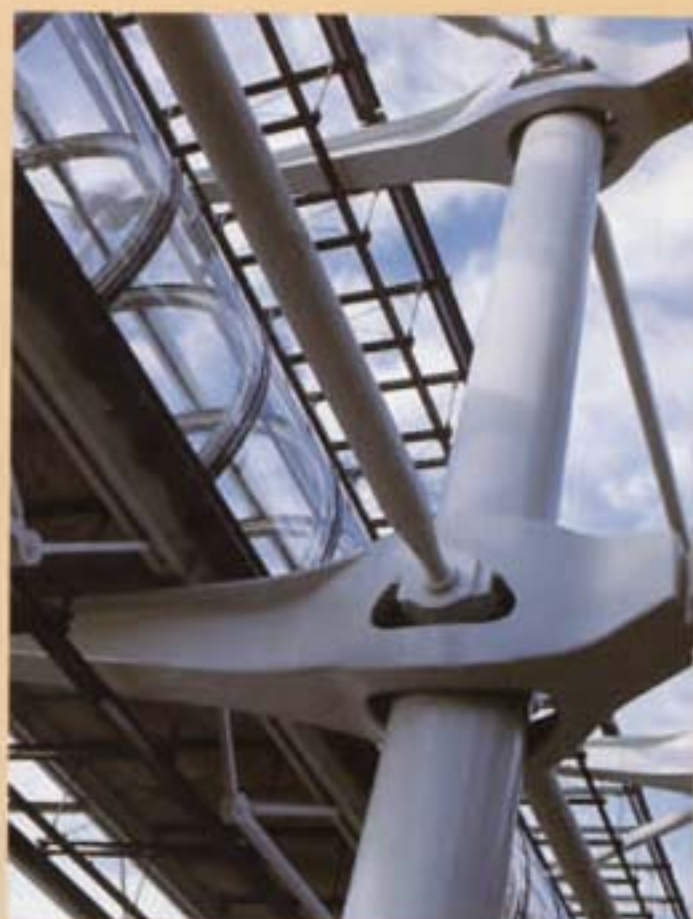
Opěrný element podlah a průchozí chodba. © Doisneau-Rapho
