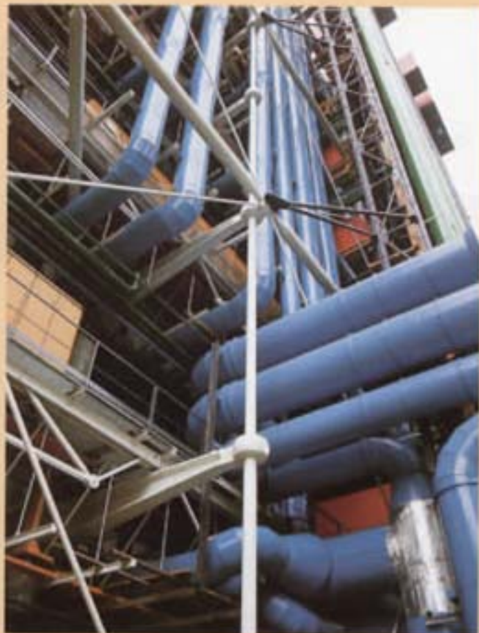
Technická fasáda s viditelnými trubkami. © Remy Poinot/Pix
