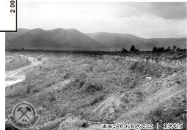
Most - Velkodůl Čs. Armády severní stěna, uložení sedimentů bývalého Komořanského jezera rok 1961
