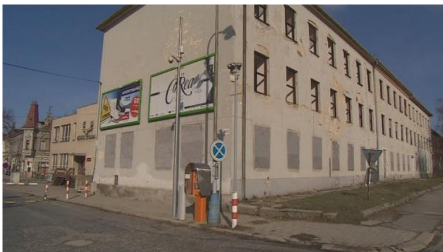
Obrázek 3 – Dnes již neexistující budova bývalé nádražní polikliniky, která byla stržena v roce 2012 (Zdroj: www.ceskatelevize.cz/zpravodajstvi - Brno)
