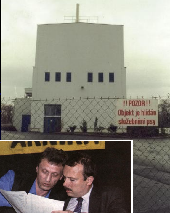
Lysá nad Labem – spalovna neb. odpadů
