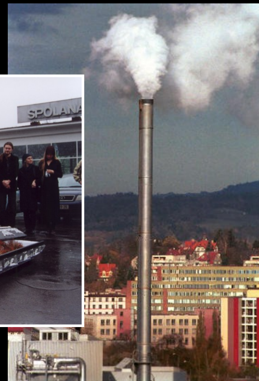
Liberec – spalovna komunál. odpadů
