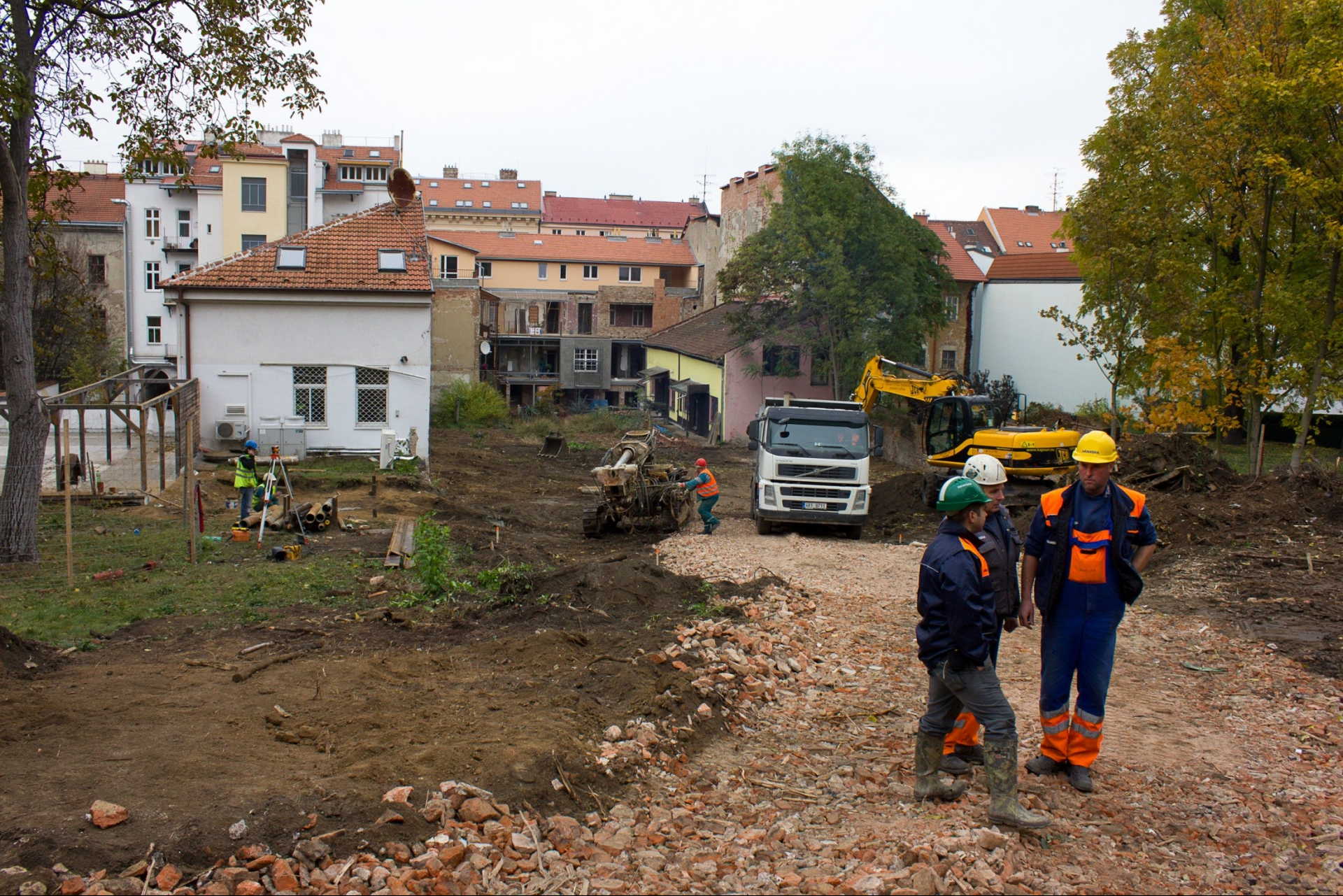
Zahájení výkopových prací /10. 2011/
