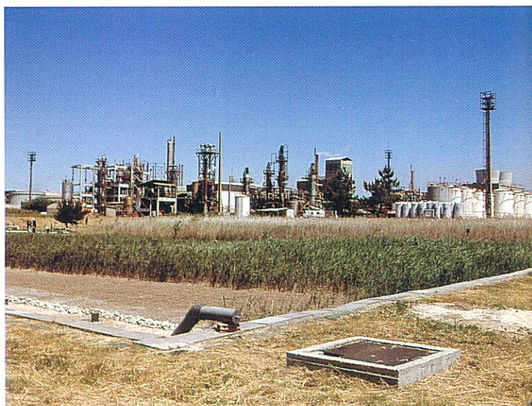
Foto 15 Kořenová čistírna pro čištění odpadních vod z výroby kyseliny dusičné. Estarreja, Portugalsko. Foto J. Vymazal.
