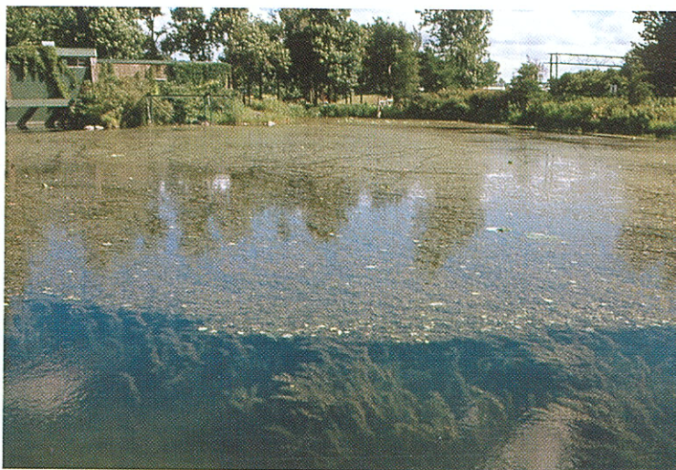
Foto 2 Umělý mokřad se submerzní vegetací pro čištění splachů z okruhu F1 v kanadském Montrealu. Foto J. Vymazal.
