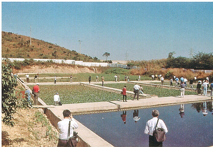
Foto 5 Kombinovaný systém v čínském Yantianu (laguna, mokřad s vodním hyacintem, mokřad s horizontálním průtokem) pro společné čištění městských splašků a průmyslových odpadních vod. Foto J. Vymazal.
