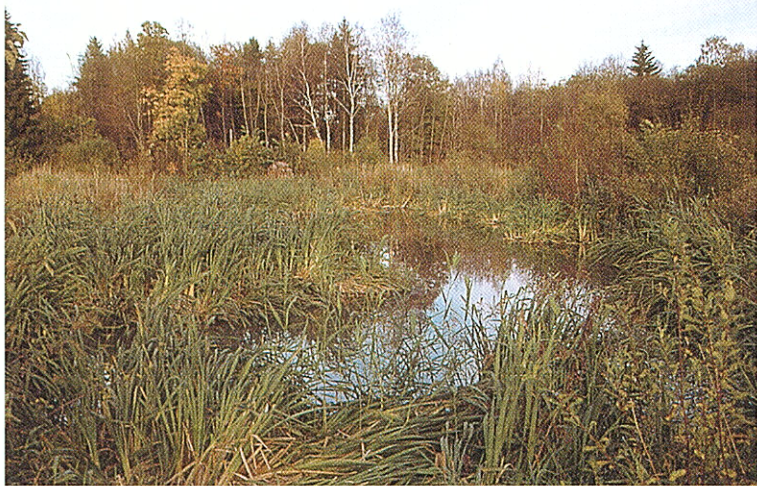
Foto 3 Umělý mokřad s volnou vodní hladinou v estonském Pölsamaa pro čištění městských splaškových vod. Foto J. Vymazal.
