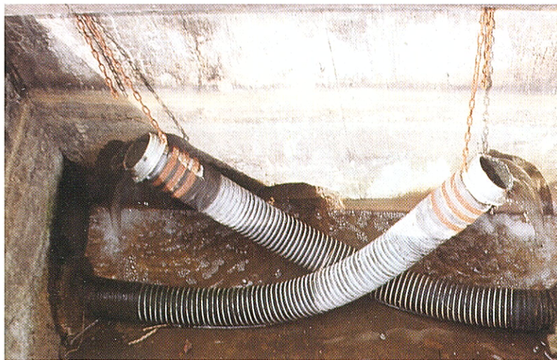
Foto 10 Regulace výšky vodní hladiny ve filtračním poli pomocí flexibilních hadic zavěšených na řetízcích na KČOV Spálené Poříčí. Foto J. Vymazal.
