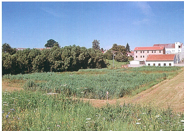
Foto 24 KČOV Čistá u Rakovníka (800 EO). Foto J. Vymazal.
