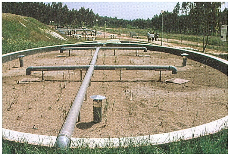
Foto 4 Umělý mokřad s vertikálním průtokem – součást kombinovaného systému (laguna, vertikální průtok, horizontální průtok) pro čištění průsaků ze skládky pevného odpadu v portugalském městě Leiria. Foto J. Vymazal.
