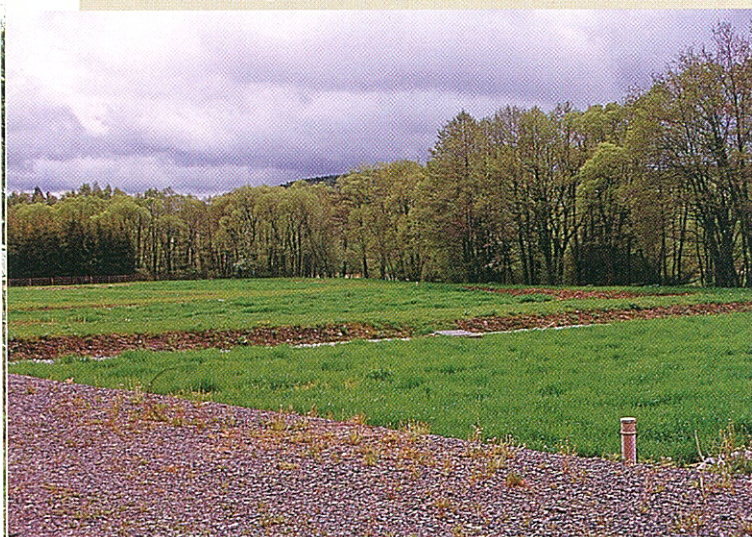
Foto 22 KČOV Obecnice u Příbrami. (Do konce roku 2004 bude napojeno 800 EO). Foto J. Vymazal.
