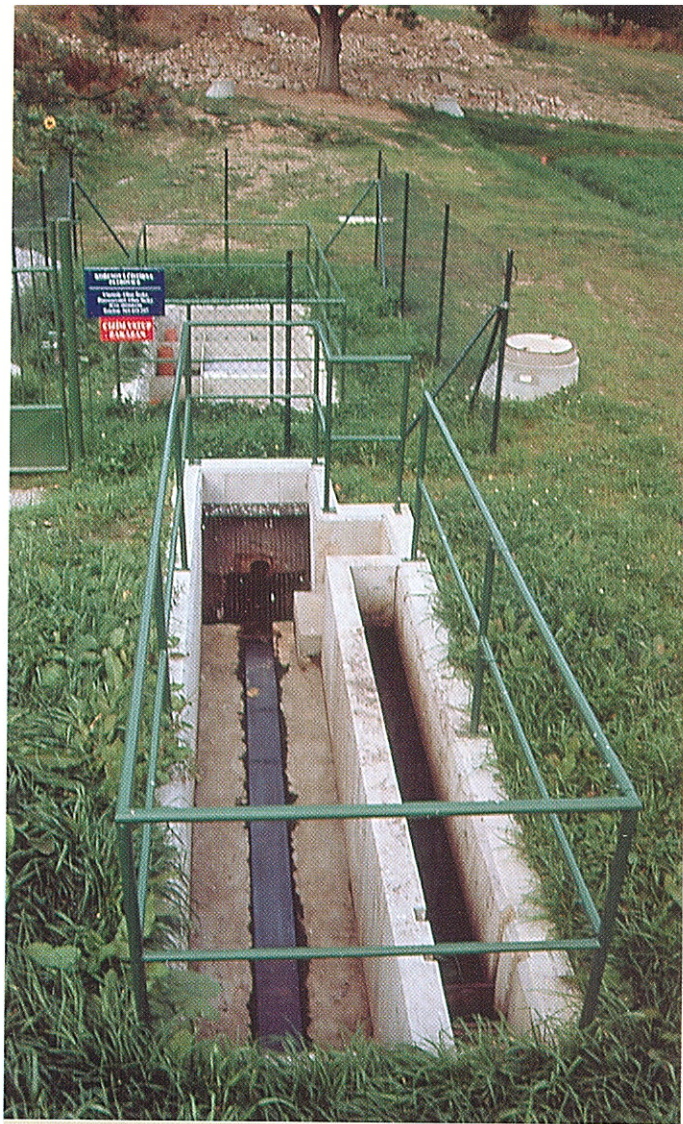
Foto 7 Předčištění (lapák písku, česle a štěrbinová nádrž) na KČOV Petrovice u Havlíčkova Brodu. Foto J. Vymazal.
