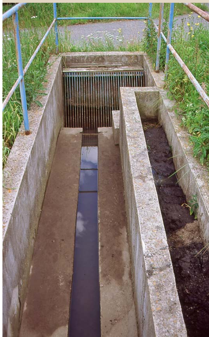
Foto 6 Lapák písku a česle na KČOV Kámen u Havlíčkova Brodu. Foto J. Vymazal.
