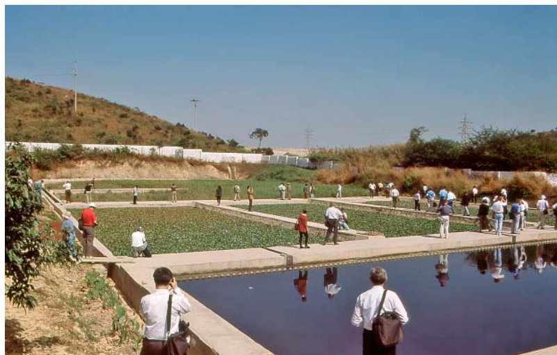
Foto 5 Kombinovaný systém v čínském Yantianu (laguna, mokřad s vodním hyacintem, mokřad s horizontálním průtokem) pro společné čištění městských splašků a průmyslových odpadních vod. Foto J. Vymazal.
