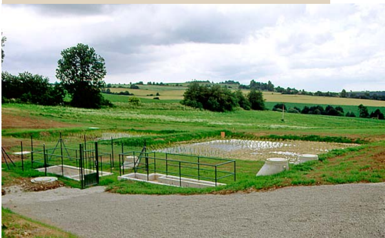
Foto 9 Celkovou plochu filtračních polí je vhodné rozdělit na několik menších ploch. KČOV Petrovice u Havlíčkova Brodu krátce po osázení v červenci 2004. Foto J. Vymazal.
