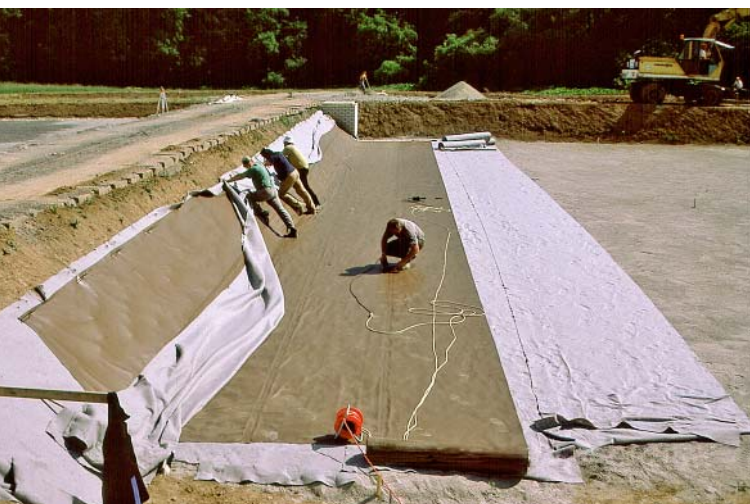
Foto 8 Plastovou fólii je nutné podložit a překrýt geotextílií. KČOV Mořina. Foto J. Vymazal.
