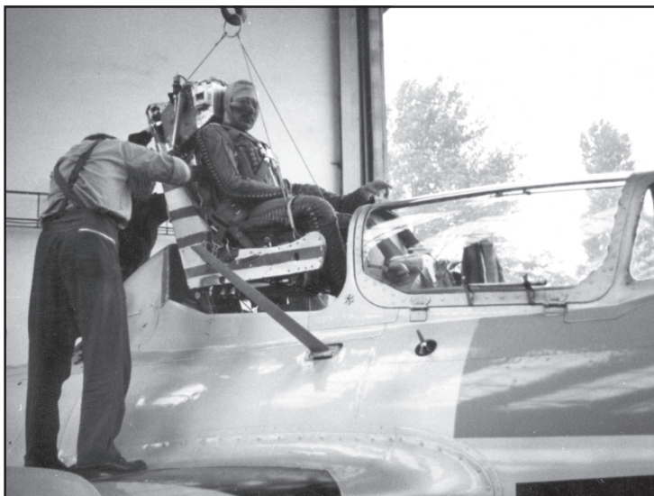
Montáž vystřelovacího sedadla s figurínou do MiG-15UTI při zkouškách záchranných systémů ve VZLÚ (archiv L+K)
