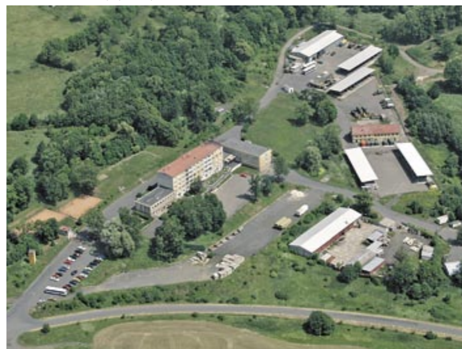
Areál Střediska obsluhy výcvikových zařízení Hradiště v Radošově
