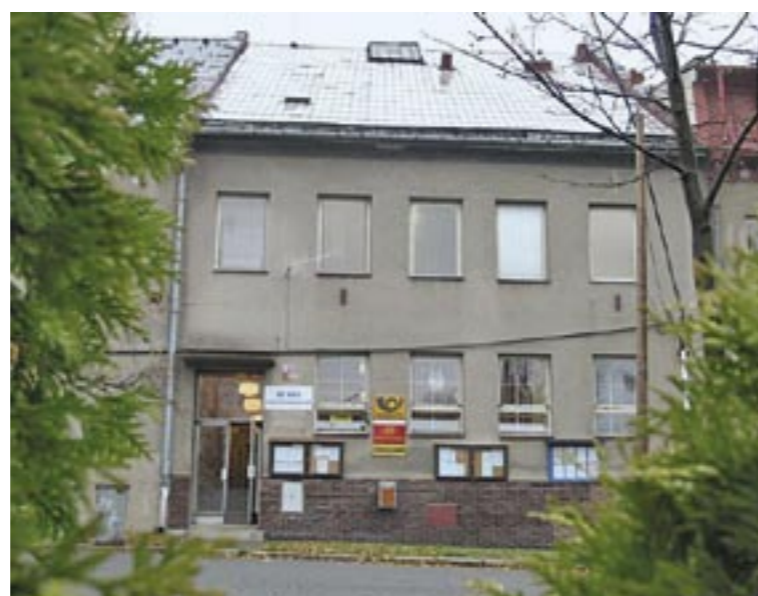
Újezdní úřad vojenského újezdu a pošta ve Městě Libavá
