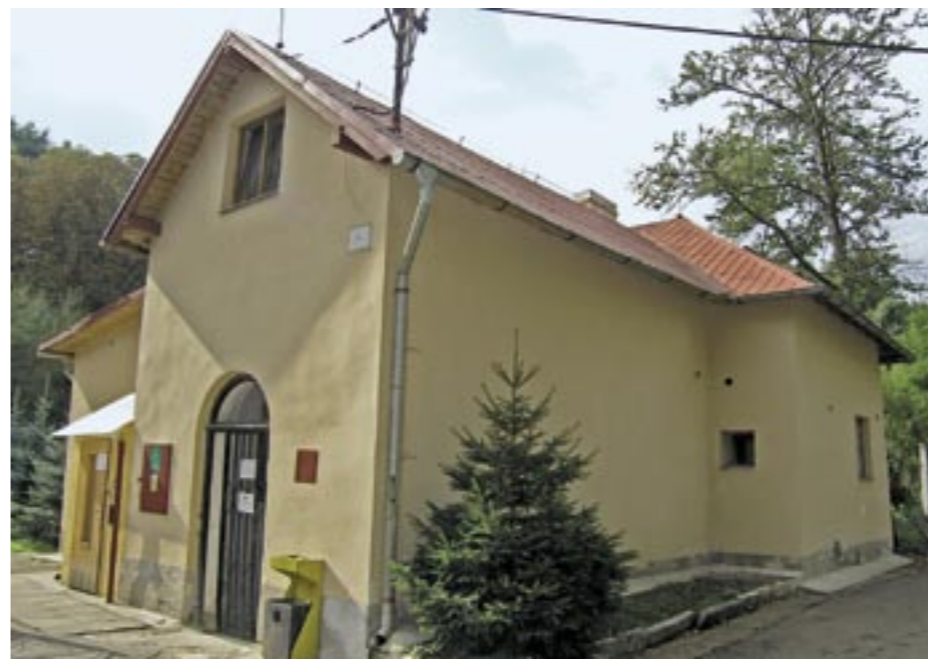
Budova v Žbletíně s pramenem minerální vody
