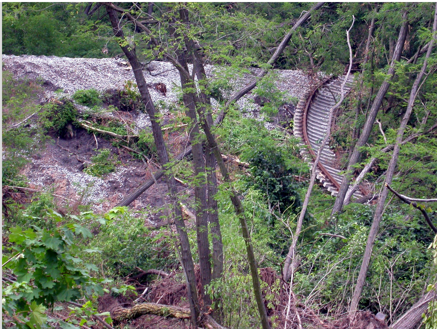
Fotografie sesuvu v km 56,3-56,5 (6. 7. 2013)
