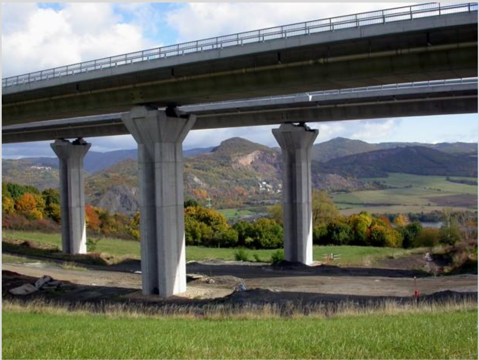
Zátiší s betonem – dálnice D8 v Českém středohoří: estakáda Prackovice (9. 10. 2017)
