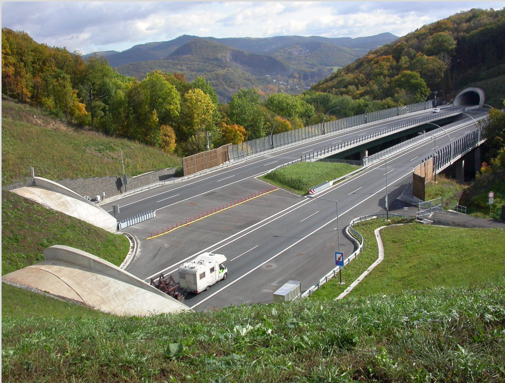
Trasa dálnice D8 mezi tunelem Radejčín (vlevo) a tunelem Prackovice (vpravo) v Českém středohoří (9. 10. 2017)
